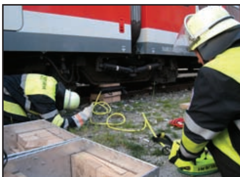
Anheben eines Laufrades mittels eines pneumatischen Hebekissens
