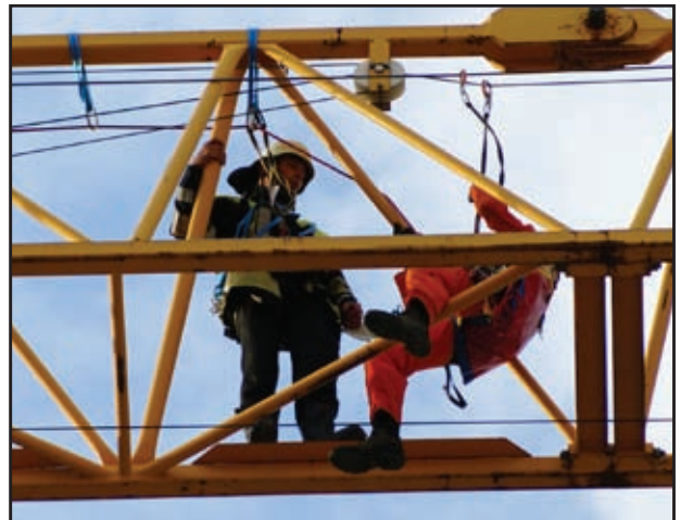
Der Gerätesatz Absturzsicherung bei einer Außenübung an einem Baukran
