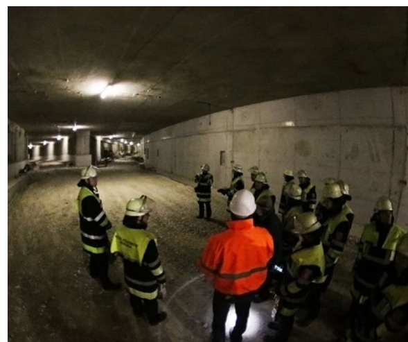
Im Tunnel unter dem Luise-Kiesselbach-Platz
